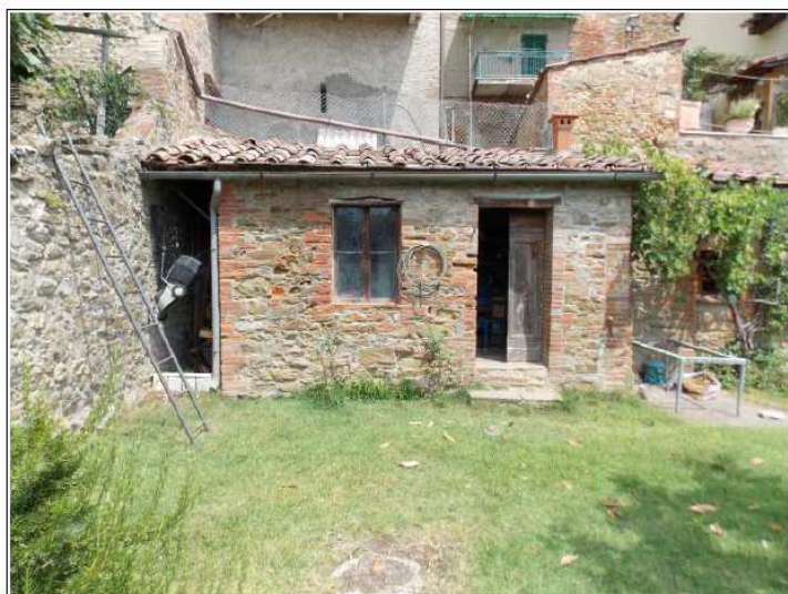
Foto n°3 – Corpo di fabbrica n°3
