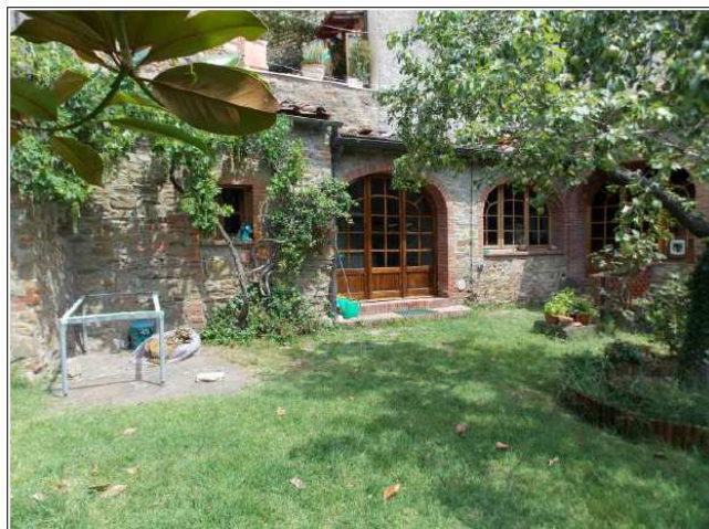
Foto n°4 – Corpo di fabbrica n°2
