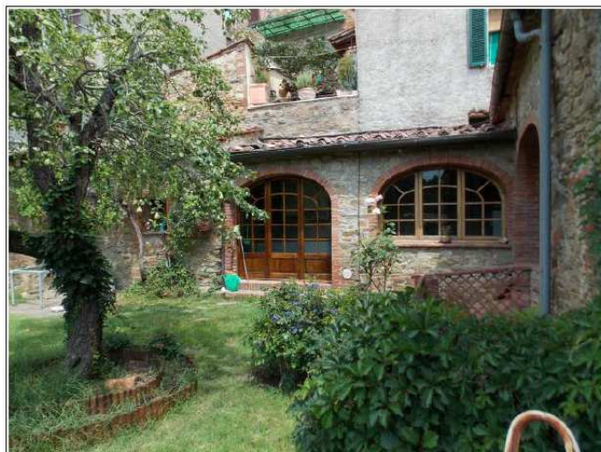
Foto n°5 – Corpo di fabbrica n°2
