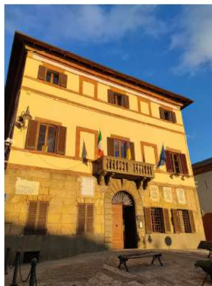
Prospetto su Piazza Garibaldi
