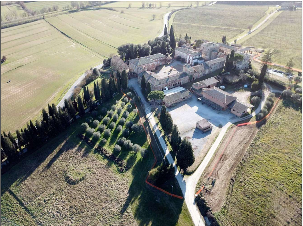
L'amorosa. Vista aerea del complesso da nordest.
