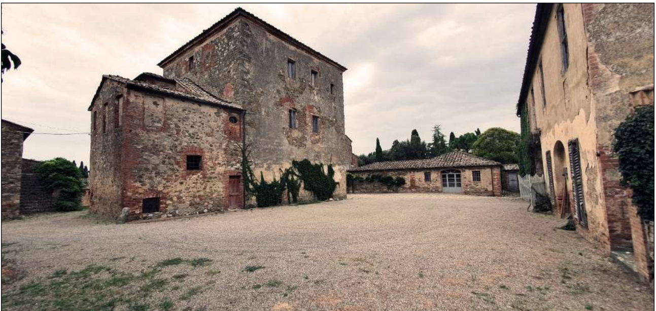
Veduta da nordovest della corte secondaria. Da sinistra sono visibili la torre, il magazzino S. Antonio e la bigattiera.
