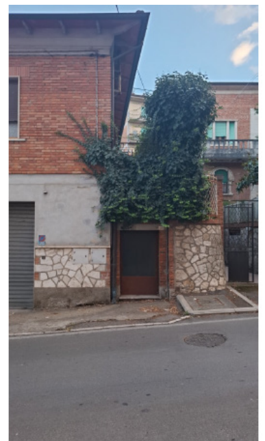
Vista da via Grassi
