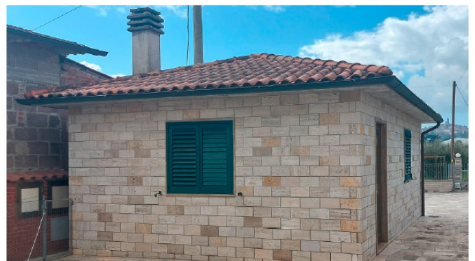
Foto 3 - Fg 52 Part. 1326 Sub. 2 (FABBRICATO "A")
