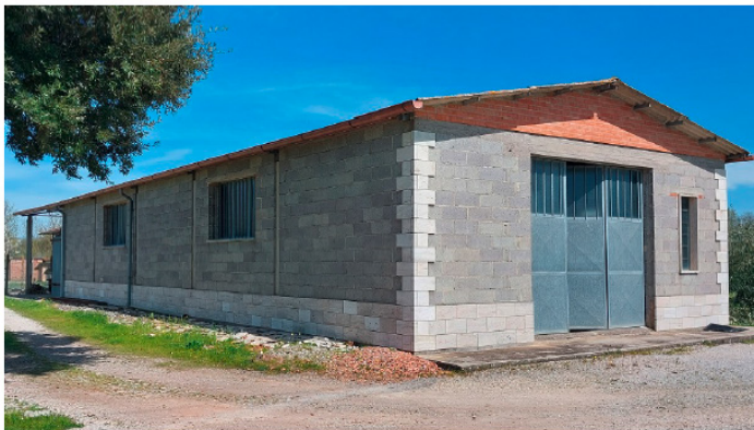
Foto 7 - Fg 52 Part. 1327 (FABBRICATO "C")
