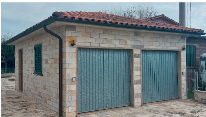
Foto 2 - Fg 52 Part. 1326 Sub. 2 (FABBRICATO "A")
