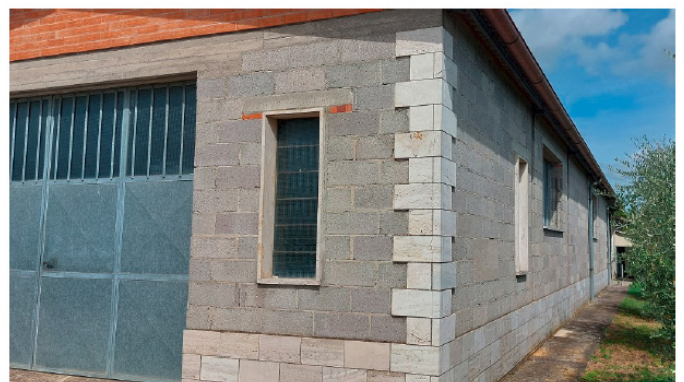
Foto 11 - Fg 52 Part. 1327 (FABBRICATO "C")
