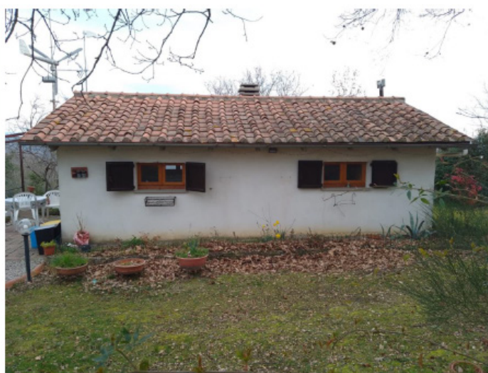
Foto n.3 – Prospetto Laterale Destro
