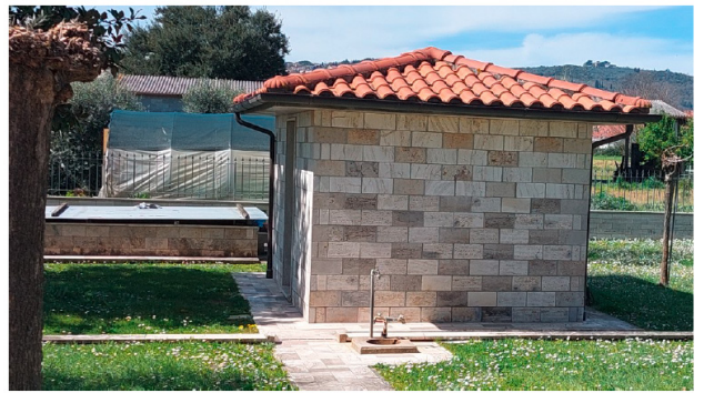
Foto 15 - Fr 52 Part. 1326 (FABBRICATO "B")
