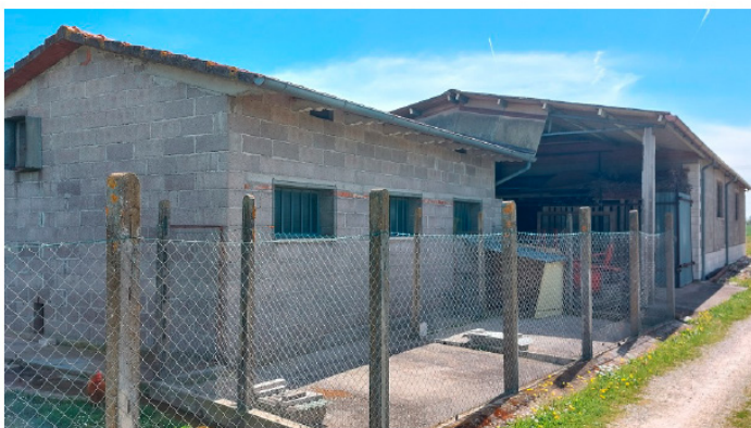
Foto 8 - Fg 52 Part. 1327 (FABBRICATO "C")
