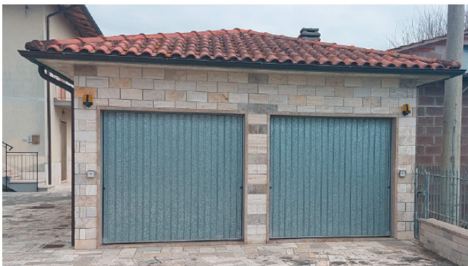
Foto 1 - Fg 52 Part. 1326 Sub. 2 (FABBRICATO "A")
