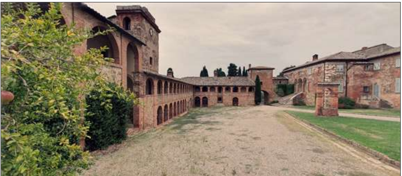
Veduta della piazza principale verso il lato nordest. Da sinistra sono visibili la loggia, la torre d'ingresso, la villa padronale e, in posizione centrale, il pozzo.
