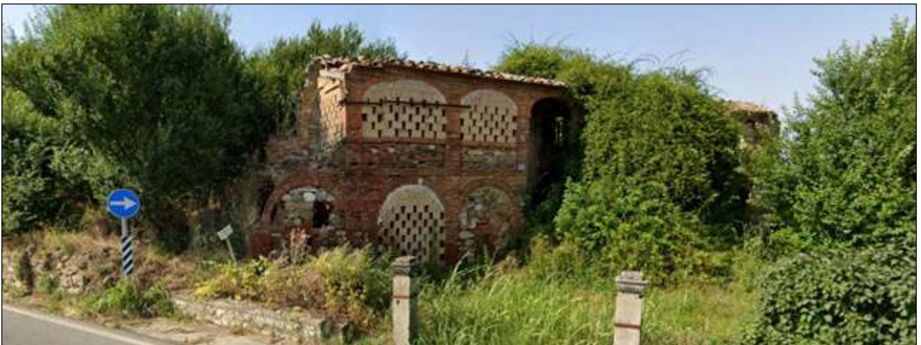
Villa Maggiore. Veduta da sudovest dell'insediamento e ripresa dell'edificio principale, ridotto a rudere
