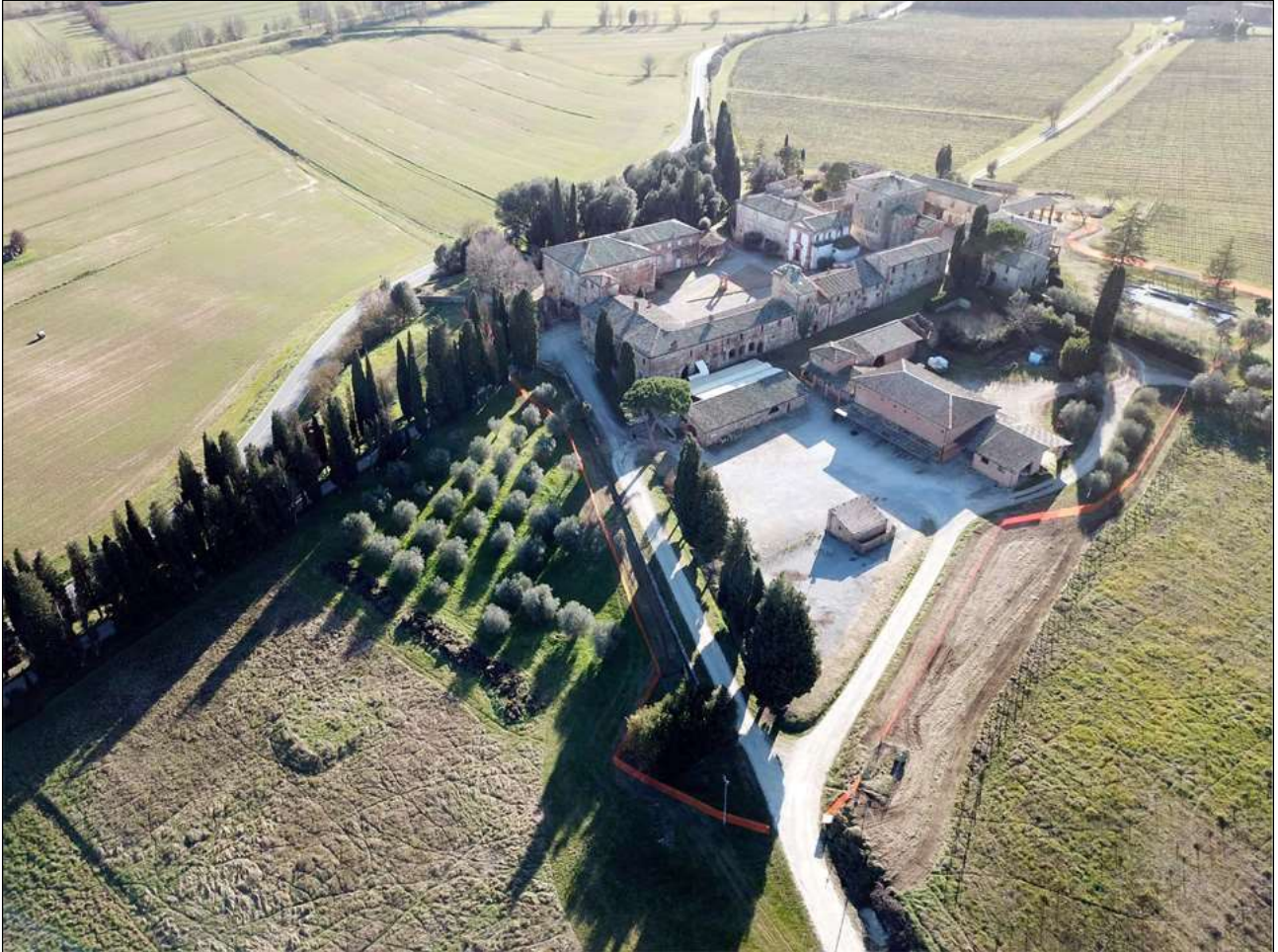
L'Amorosa. Vista aerea del complesso da nordest.
