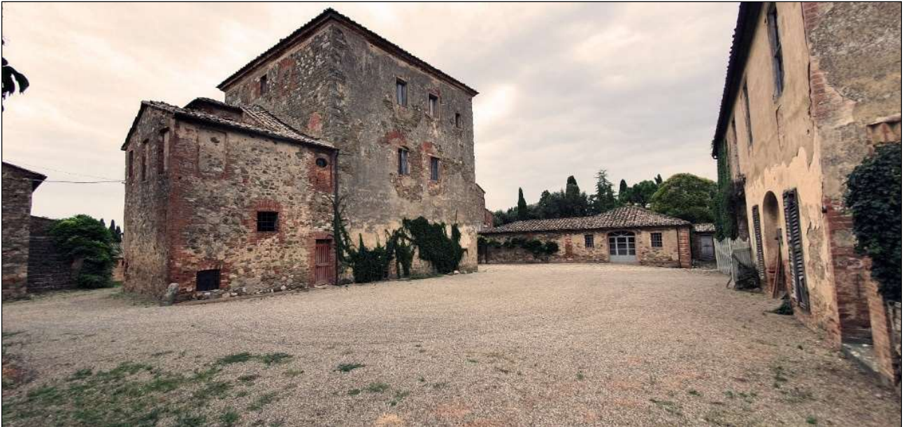
Veduta da nordovest della corte secondaria. Da sinistra sono visibili la torre, il magazzino S. Antonio e la bigattiera.
